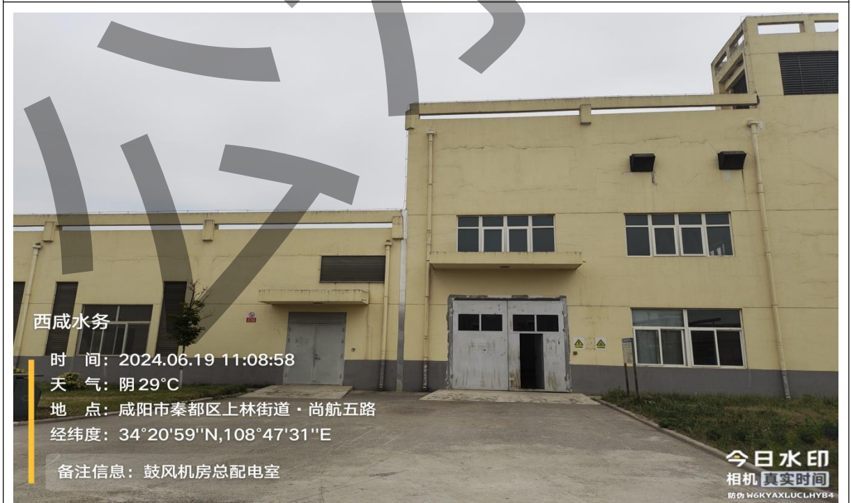
鼓风机总、总配电室
